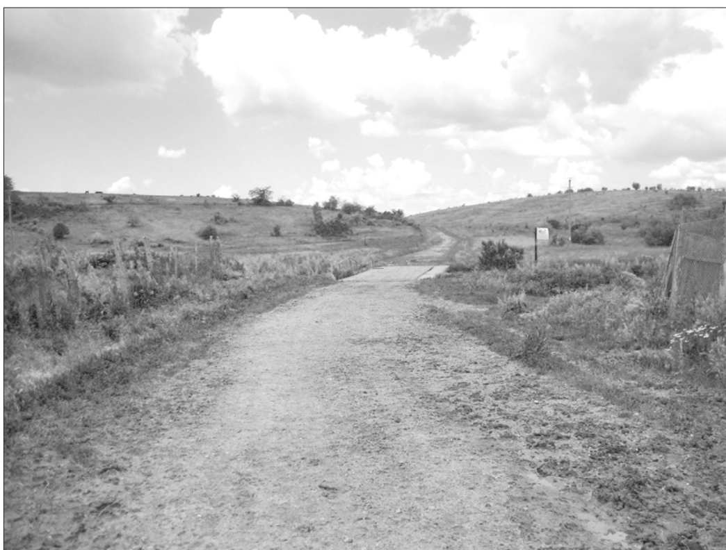
Primăria Mischii a obținut 1.000.000 de euro, bani europeni, pentru modernizarea drumurilor
