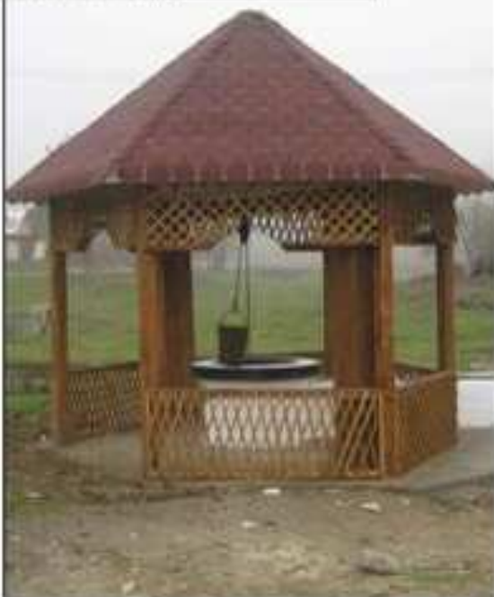
Primăria a reamenajat și modernizat o fântână din zona Călinești. Proiectul va continua și cu alte fântâni din toată comuna Mischii care vor fi reabilitate în cel mai scurt timp
